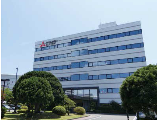
静岡工場外観
